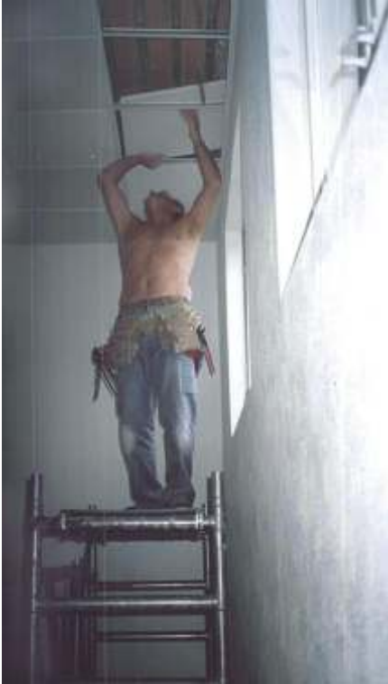
Bernt Berggren sätter de sista gipsplattorna i taket på den nära 6 meter höga entréhallen.
