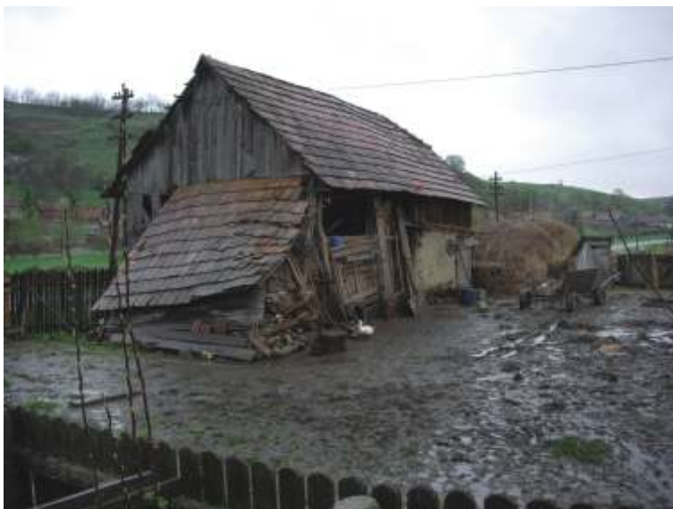
Familjens ladugård har plats för två kor. Gårdsplanen är inte lämpad för regn.
