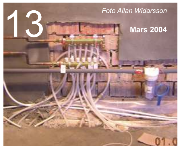
Huset har försetts med behaglig golvvärme genom sex separatstyrda slingor
