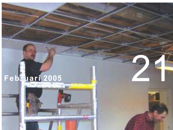
Kent Jonsson och Erik Eriksson från AB JB-akustiktak monterar huvuddelen av akustiktaken
